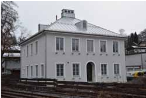
nach der Sanierung Ende 2017 von Nordosten
