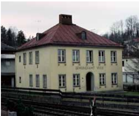
Das Gebäude im Jahr 1981 von Nordosten, in unveränderter Form zu 2018
